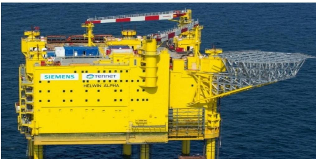
La plate-forme de transformation peut être un élément très lourd, (on voit ici une plate-forme de 500 MW qui pèse quand même 12 000 tonnes), et il faut signaler que pour exporter une grande puissance à une grande distance par des câbles électriques sous-
