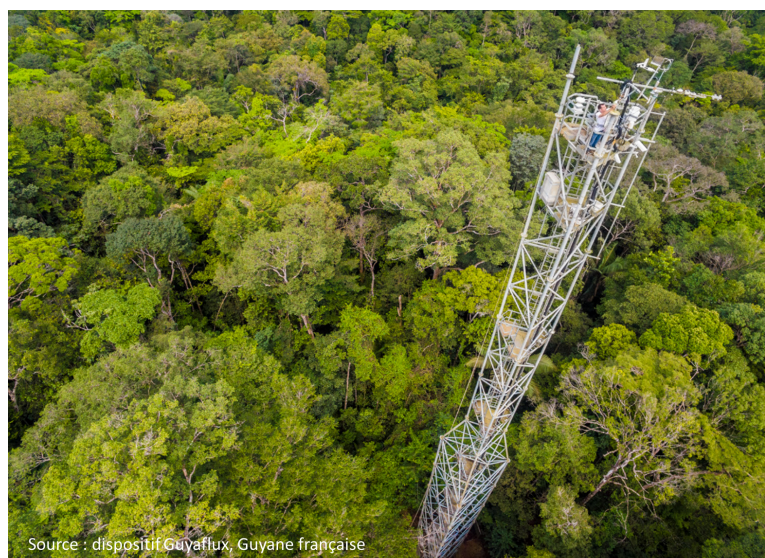
Tour de mesure de différents gaz
