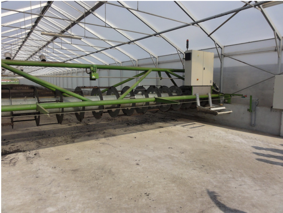
– Retournement des boues par robot scarificateur
