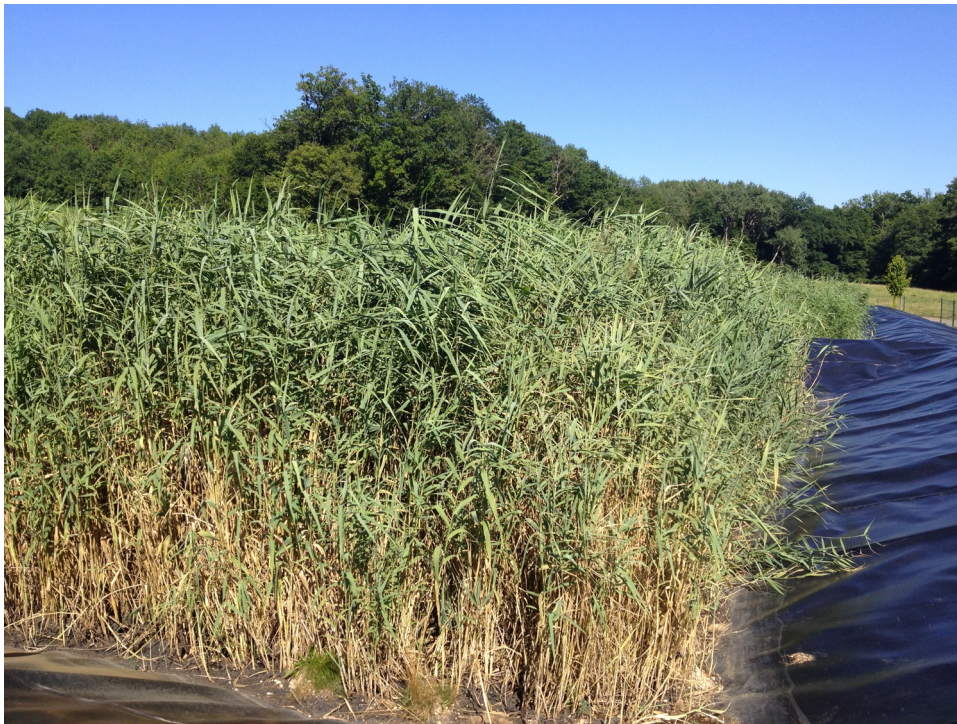
Lit de séchage planté - Station de Vieux-Frerrette (68)
