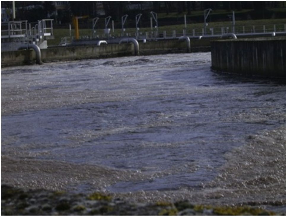
Bassin d'aération de Limoges (87)
