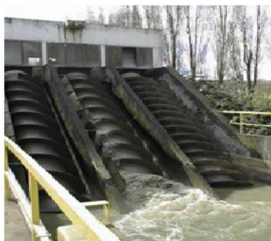
Image 11 Vis d'Archimède réducteur de vitesse.
