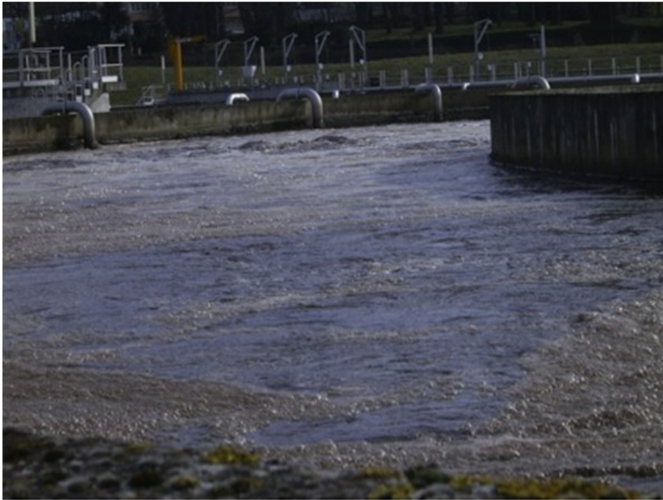
Bassin d'aération de Limoges (87)
